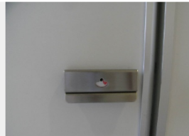
図1. 今回の事例となった解錠に専用工具が必要なドア鍵
