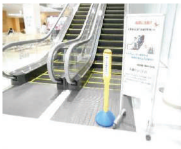
<昇りエスカレーター入口>
