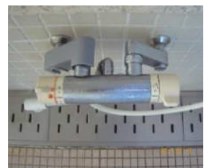
④ 介助浴室カバー設置後
