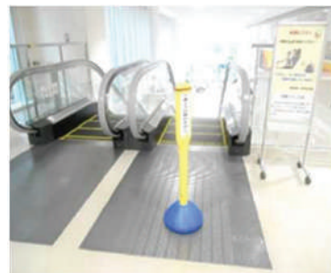
<下りエスカレーター入口>
