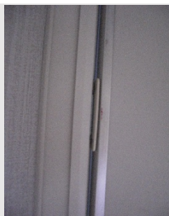
アコーディオン式カーテン ①固定が外れた状態のフック
