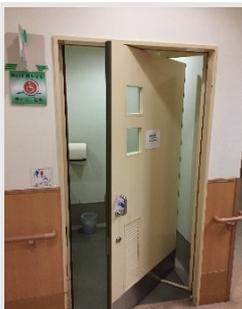
扉を手前に引くとスライドして開閉します。赤丸印のついたレール台の中で、吊り金具が破損し扉が床面に干渉し開閉しない状況でした。
