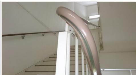
Photo② 手すり下部構造 (チューブ挿入済)
