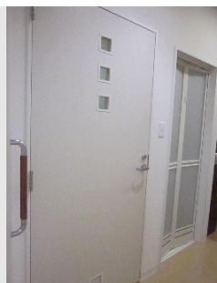
トイレドア全体
