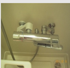
② シャワー浴室カバー設置後
