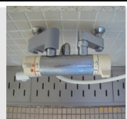
④ 介助浴室カバー設置後
