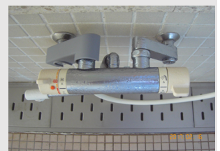
【熱傷防止カバー設置後】
