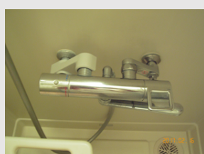
【熱傷防止カバー設置後】
