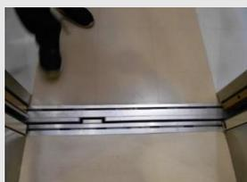
2016年1月に新築稼働しているエレベーターの為、隙間・段差はほぼない。
