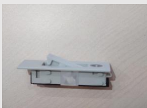
換気のためのストッパーを出して使用することが多い
