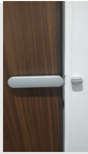
開錠後ロックが外れ、スライドバーをさらに中側に押し込められるため、ドアが外開き出来る
