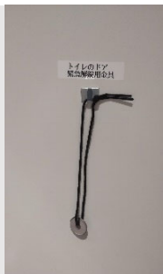
丸ワッシャーをトイレ 内スロップシンク (SK) 内に設置
