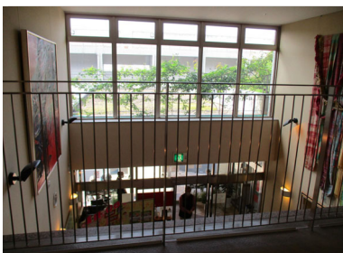
2階病棟の手すり（柵）全体
