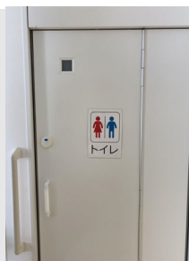
トイレ扉の外観（正常に閉じている状態）
