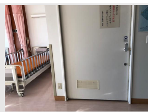
がらり設置後の トイレ扉（閉）
