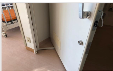
がらり設置前の トイレ扉（開）
